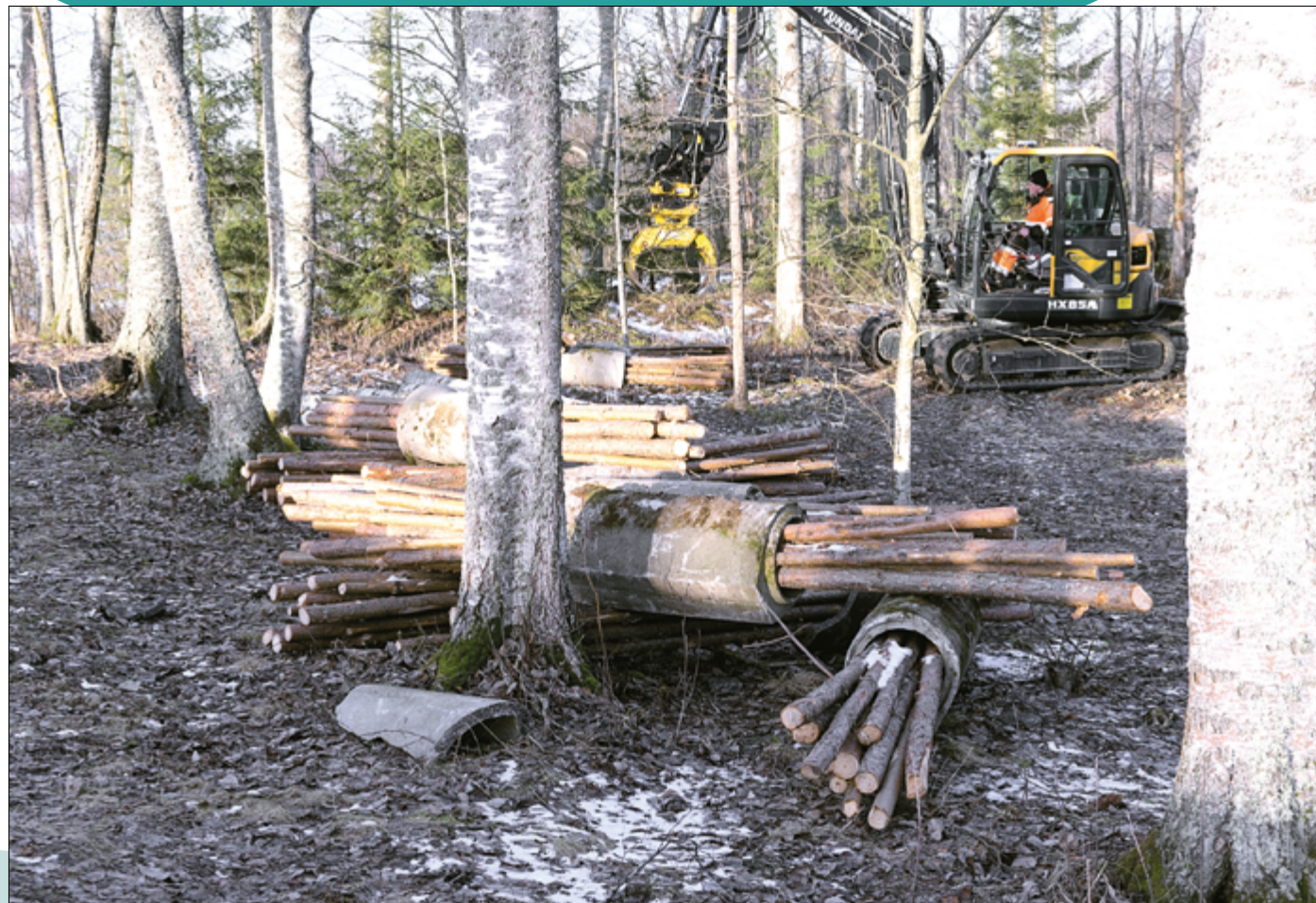
Talkootyönä valmistetut uppopuupuhdistamon rankaniput ovat valmiita asennettavaksi.
